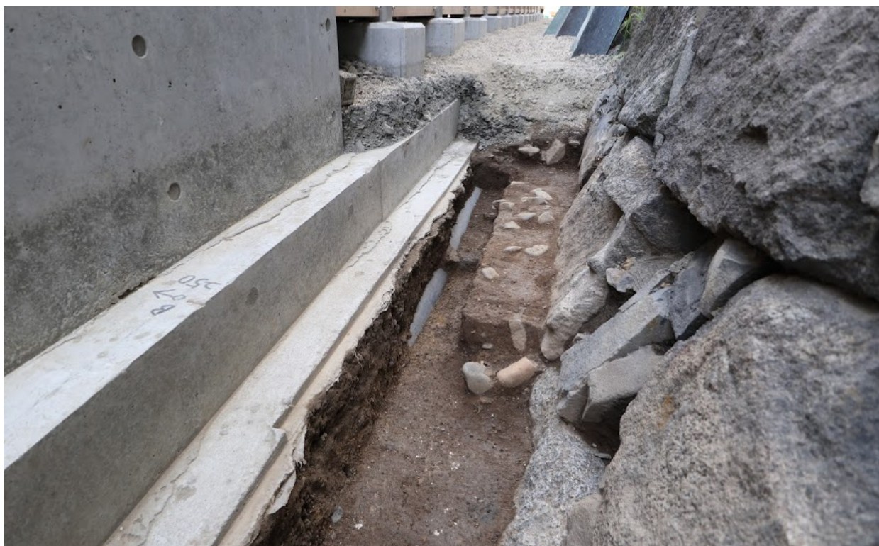
図3 本丸の保護盛土層を掘り抜いて本丸の遺構面を掘削した本丸御殿付帯施設の基礎
